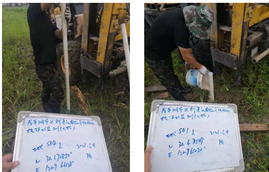
图 5.2-2 地下水建井照片
